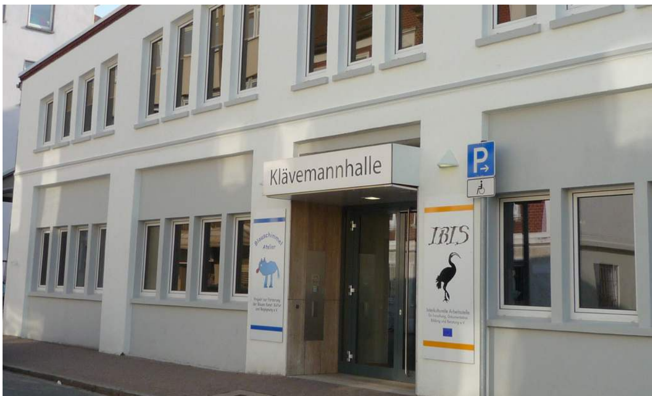
IBIS-Gebäude in der Klävemannstraße © IBIS e.V.
